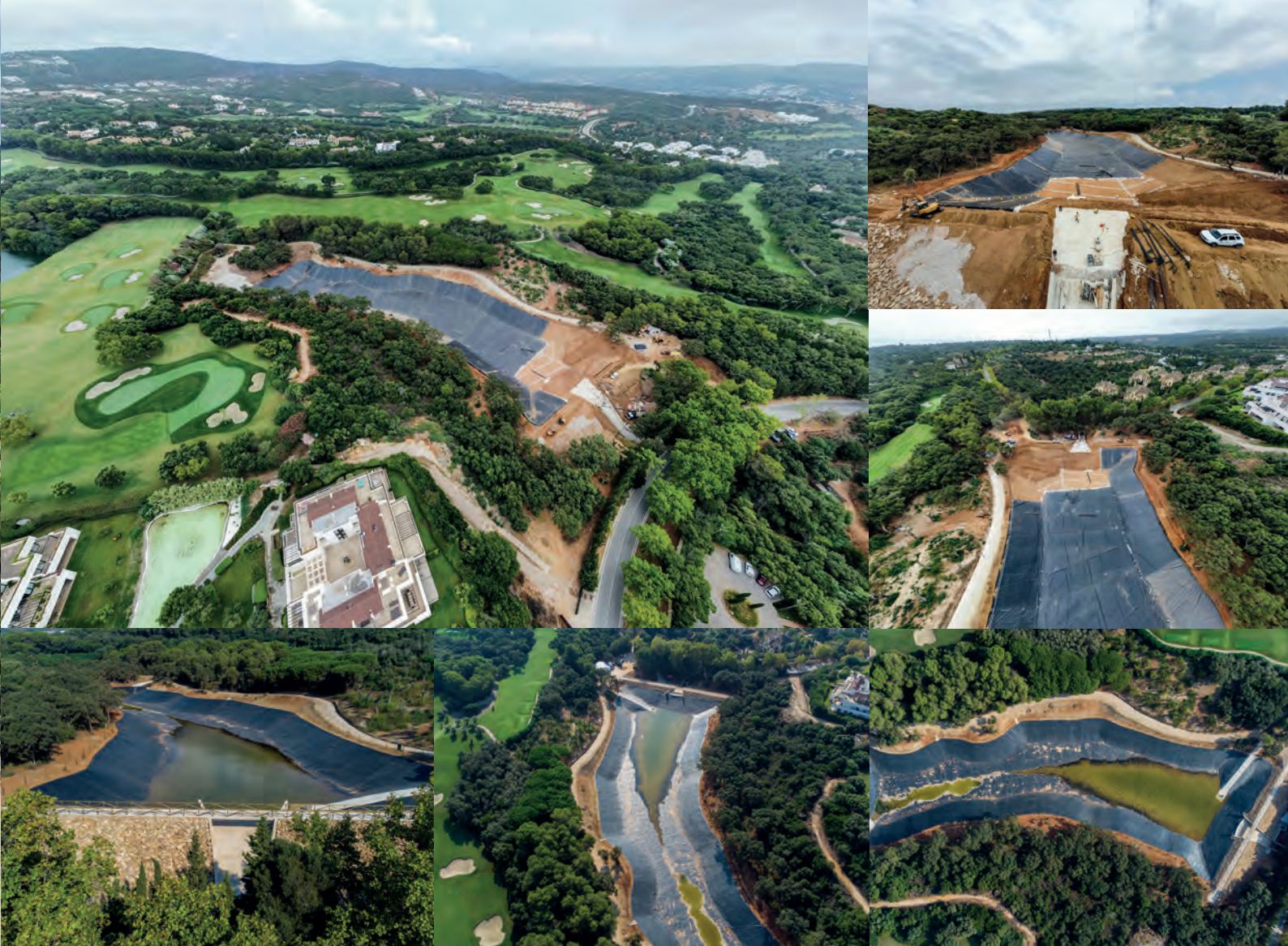
Fotos aéreas tomadas durante las obras de construcción del lago
